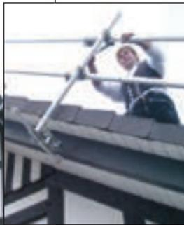
Die Ortgangsicherung wird am Giebel eingesetzt und dient der Absturzsicherung. Die meba Ortgangsicherung darf verwendet werden als Absturzsicherung im Sinne der DGUV-Vorschrift 38 „Bauarbeiten“ für Arbeiten an und auf Dächern bis zu 60° Neigung. Geprüft und zugelassen nach DIN EN 13374-A für Aufbauhöhen bis max. 40m über Gelände. Zum Einsatz kommen entweder Gerüstrohre oder Gitterträger.
