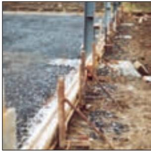
Schalhilfe zur Erstellung von Bodenplatten.
