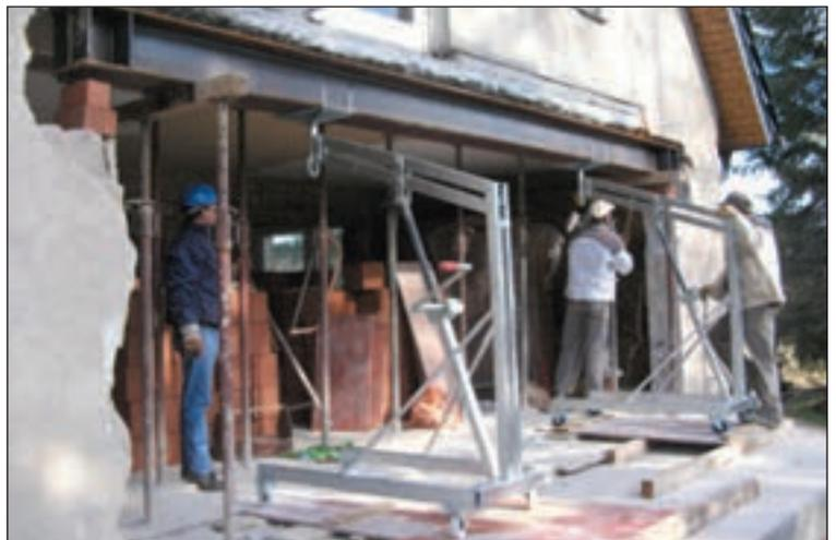
Einsatz eines Stahlträgers mittels zweier Kragarmlifte. Durch Kurbeln lässt sich der Stahlträger in die gewünschte Höhe befördern.
