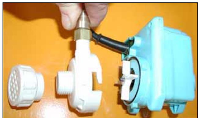
Bild 5.4 Sieb und Deckel von der Tauchpumpe demontiert
