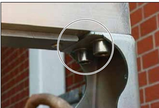
**Bild 5.22** Befestigungsschrauben der Führungsschiene (von unten gesehen)
