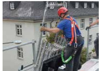
Leichtes und sicheres Entladen des Gerüstmaterials
