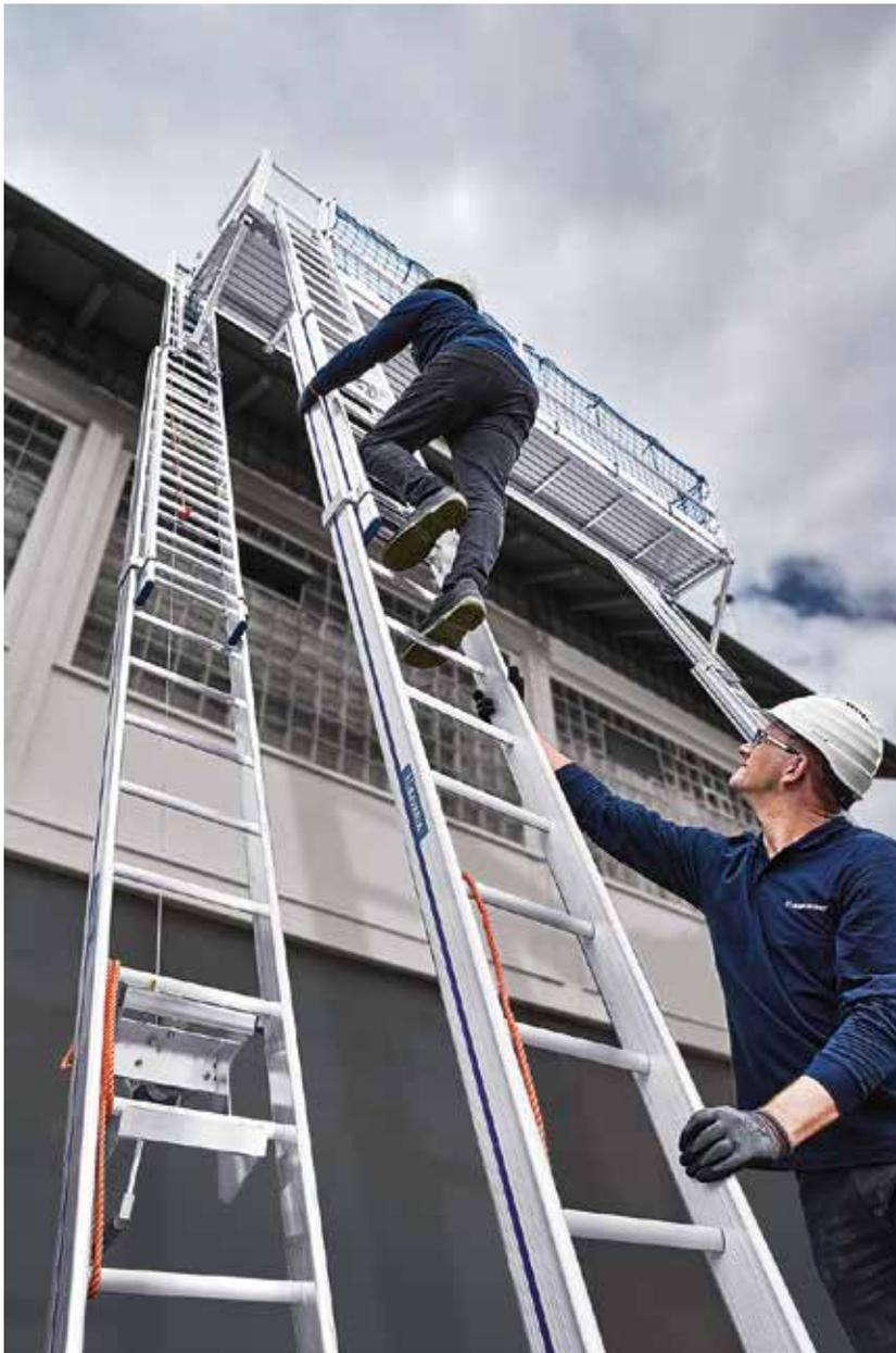
Die Standsicherheit der Zugangsleiter gewährleistet eine Leiterkopfsicherung, welche bereits ebenerdig am Gerüstboden montiert wird. Dadurch wird ein seitliches Wegrutschen der Leiter sicher verhindert. Eine Absicherung von der Leiter aus ist also nicht nötig.
