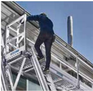
Die Arbeitsplattform wird über eine separate Zugangsleiter bestiegen. Die Zugangstür schließt mittels Federzug selbstständig.
