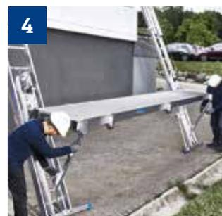
4 Arbeits-Plattform und Stütze auf dem Transport-Schlitten einhängen.
