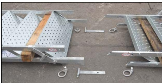
Die unteren Enden der Treppenholme der oberen Treppe werden in die oberen Enden der Treppenholme der unteren Treppe eingeschoben,...
