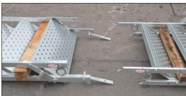
Die zu verbindenden Treppen müssen vorbereitet werden. Hilfreich ist zunächst das Einlegen von gleich starken Kanthölzern, die die Holme beider Treppen im selben Abstand halten. An der unteren Treppe sind am oberen Ende die Kranösen und die Befestigungslaschen, an der oberen Treppe sind am unteren Ende die Kranösen zu demontieren.
