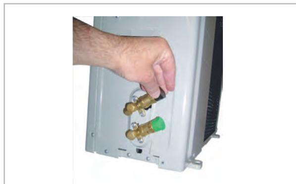
Abb. 29: Schutzkappen entfernen
